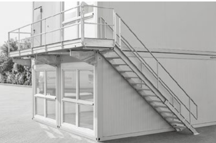
Buitentrap en bordes Directe toegang tot de eerste verdieping
